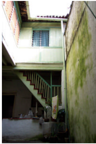
照片四、邱公司厝 33 號中庭天井。是一室外的空間可直接收集屋頂的雨水流至外部。所見的樓梯亦即照片三中的樓梯。
