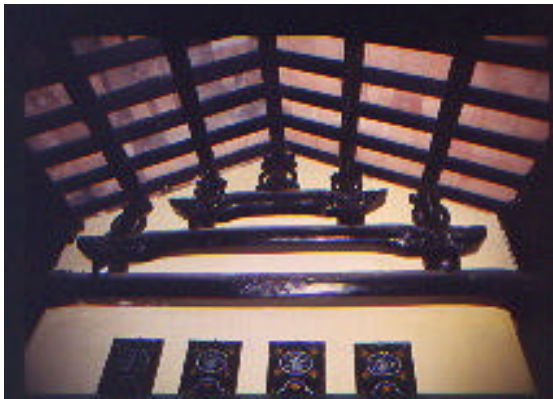
照片十三、越南傳統店屋屋架。其中有建築結構受到中國福建傳統建築通樑系統結構之影響。
