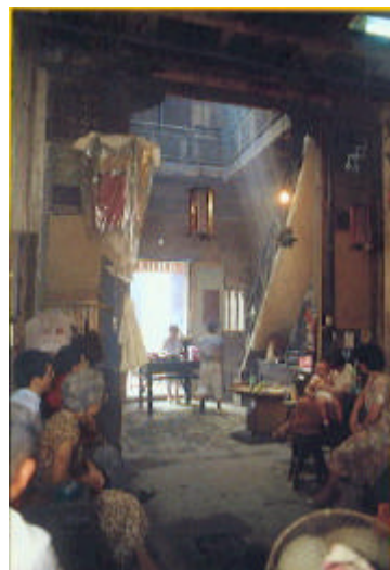
照片十一、第三進廳堂空間。施以樓井之作法，顯現鹿港傳統店屋每一進建築都有上下的樓梯、樓井、前後承重牆的獨立特性。
