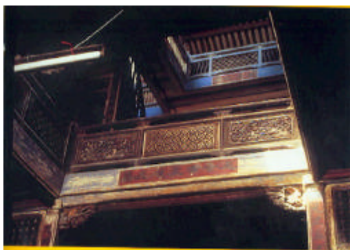
照片八、自一樓第一進建築樓井仰視二樓樓井照片。鹿港的樓井均施於室內，不同於檳城的天井可吸收自然雨水。
